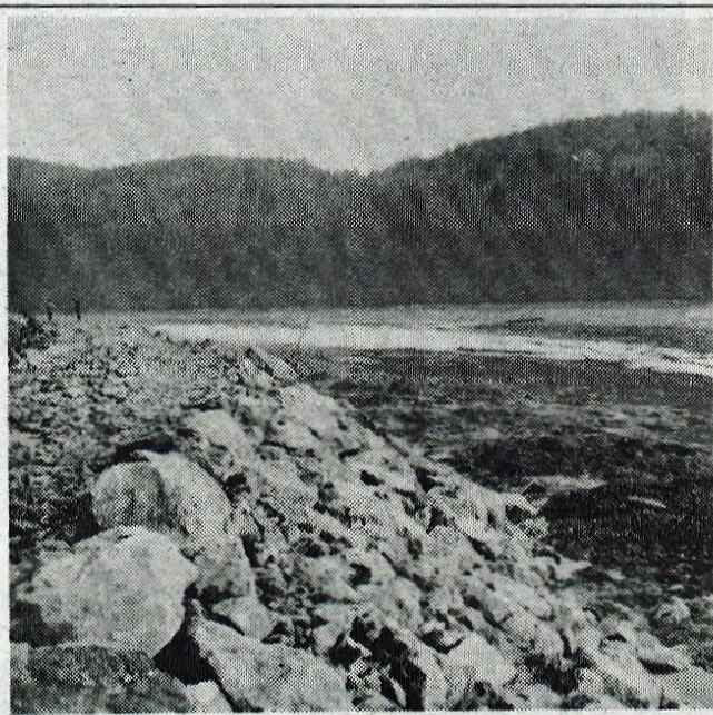
S skalami iz Kamne Gorice sta Gradis Ljubljana in Podjetje za urejanje voda Celje že zgradila 500 metrov dolg nasip. Po njem bo vodila tri metre široka pot, kotanjo za njim pa bo napolnilo 88.000 kubičnih metrov blata, ki ga bodo potem prekrili z zemljo in zatravili.
