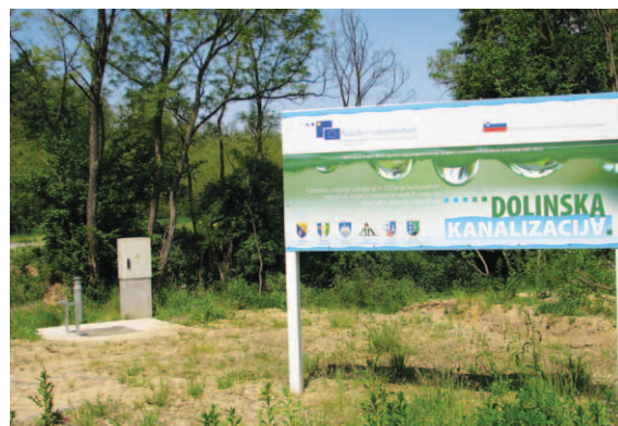
V okviru Dolinske kanalizacije so vključeni naslednji posamezni projekti: kanalizacija in čistilna naprava Beltinci, kanalizacija Dobrovnik, kanalizacija Lendava, kanalizacija Moravske Toplice, kanalizacija in čistilna naprava Razkrižje, kanalizacija in čistilna naprava Velika Polana
