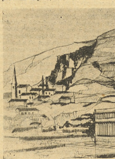
Strojnica hidrocentralne Osp. Nad strojnico je videti tlačno cev.
