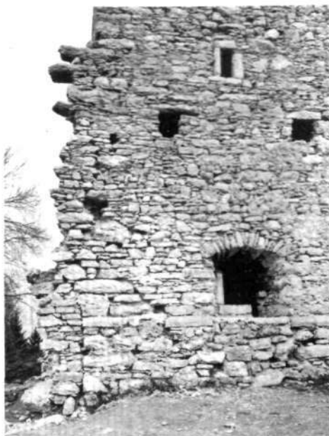
Slika 7. Južna stena zvonika z vključeno in porušeno južno steno prezbiterja. Vidne so okenska odprtina zakristije v pritličju in manjše pravokotne zračne in ogledne line v nadstropju. Opaziti je strukturo zidu in način zidanja
