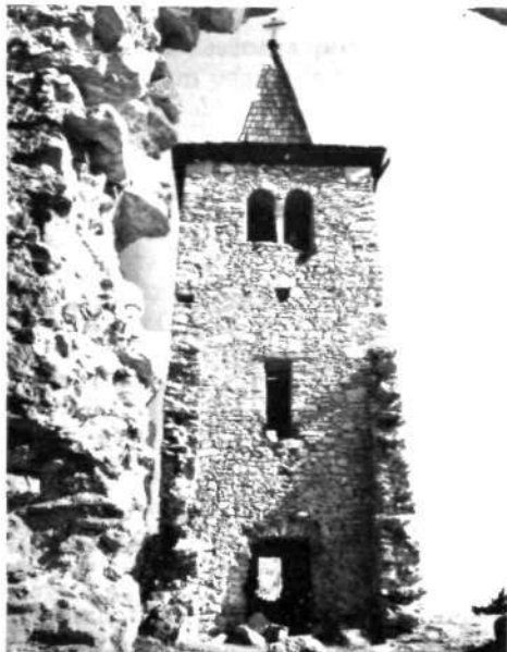
Slika 6. Zahodna stena zvonika je vhodna stena prezbitnerija. Ob severni in južni strani sta se ohranila v ruševinah zidova prezbitnerija. V pritličju je bil vhod v zakristijo, v nadstropju pa vhod v zvonik
