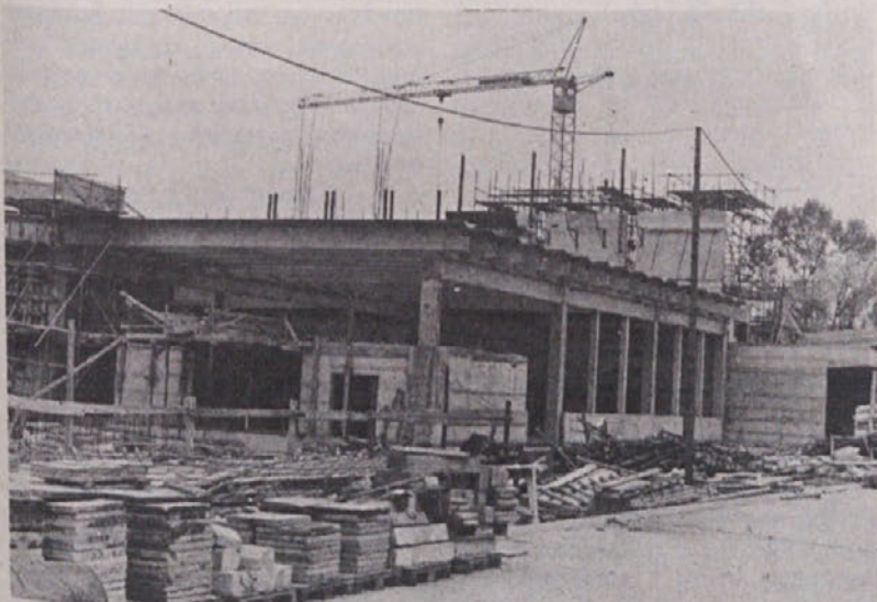
Gradbena dela na Lekovem novem projektu v Mengšu hitro napredujejo
