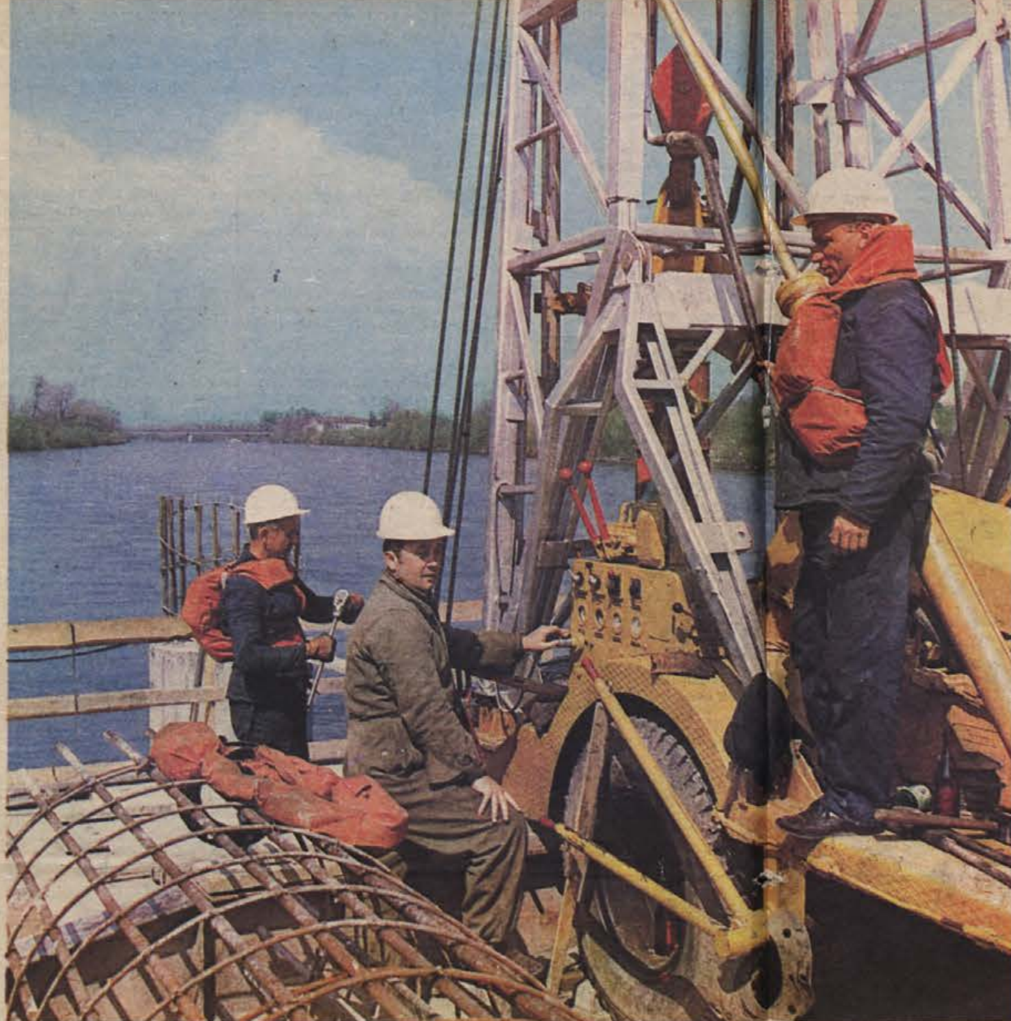
Najzahtevnejše delo pri graditvi novega brežjskega mostu čez Savo je bilo betoniranje železobetonskih pilotov v rečni strugi. Po nevspeh, ko se je potopil velik splav z drago napravo, so strokovnjaki zagrebske Geotehnike delo uspešno opravili. (Foto: M. Vesel)
