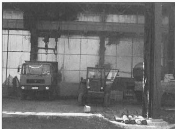
Na gradbišču dela intenzivno potekajo.
