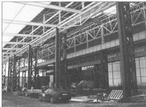
Pogled v notranjost hale teške kovačnice
