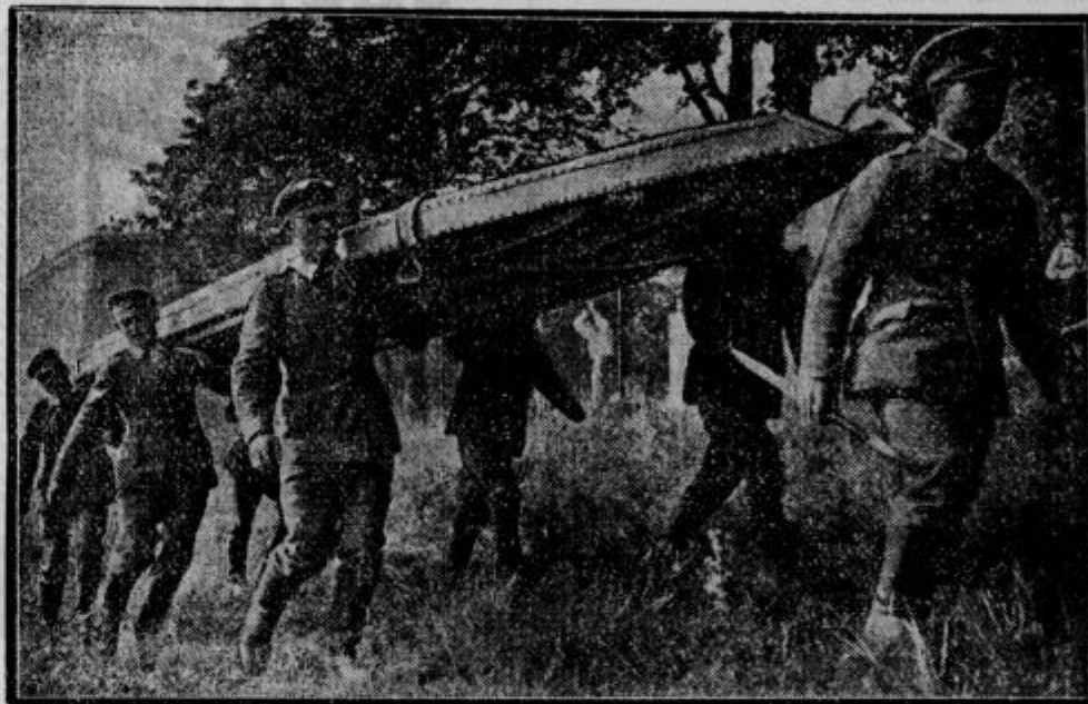
Čoln iz jekla. Pijonirji nemške armade so imeli vaje. Gradili so most. Pri tej priliki so prvič uporabili nove čolne iz jekla, ki se dajo zložiti.
