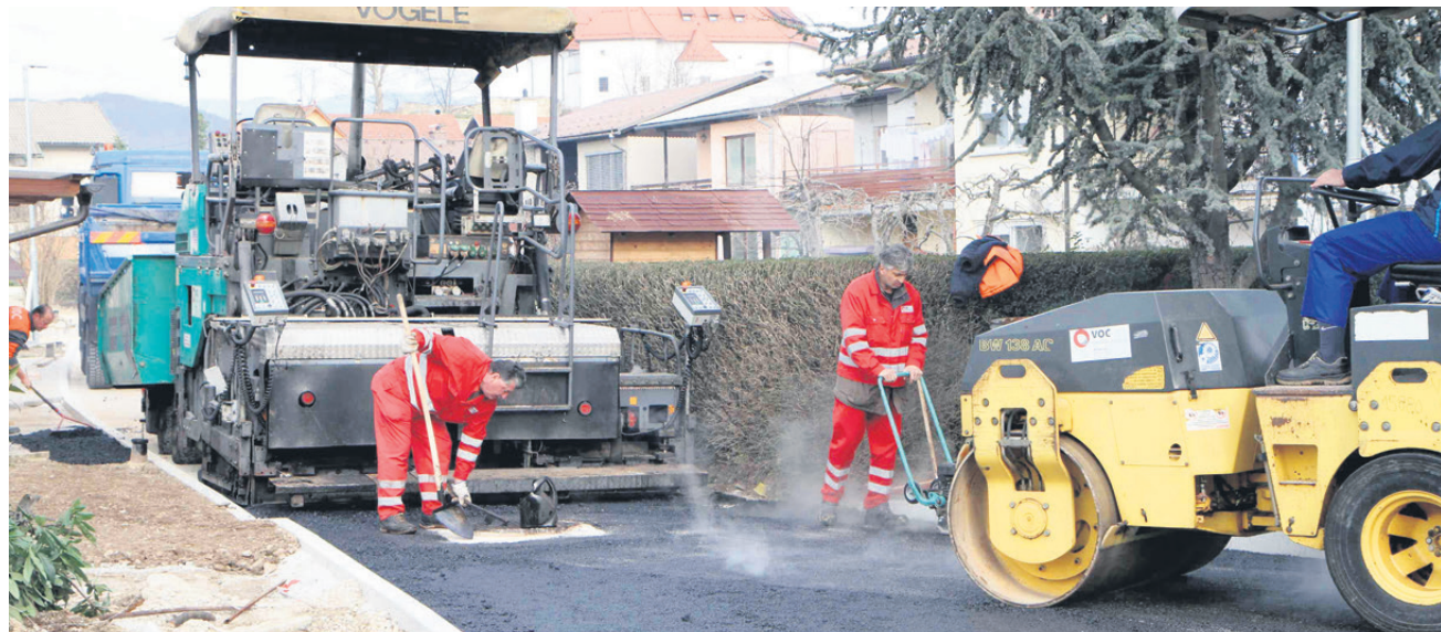
Stroji so na polzeli brneli tudi tik pred prazniki. Cestišče je tako v zadnjih marčevskih dneh dobilo novo preobleko, ulice pa so zasijale v novi podobi.
