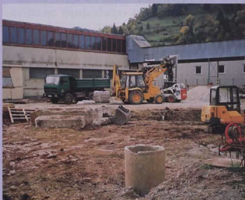
Dela pri izgradnji nove stavbe so v teku
