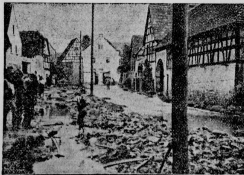
Pretekli teden se je utrgal nad Turingijo v Nemčiji oblak. Vso noč je lilo kakor iz škafa in nižje ležeče predele v Turingiji je voda poplavlila. V vasi Trebnitz je drla voda s tako silo skozi vas, da je razkopala glavno cesto. Seveda je tudi zalila vse kleti; na polju pa uničila ves pridelek.
