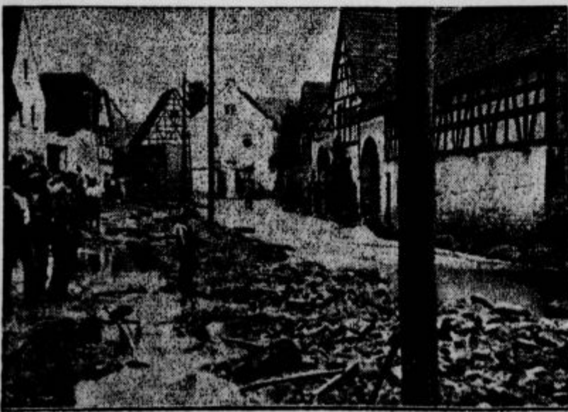
Pretekli teden se je utrgal nad Turingijo v Nemčiji oblak. Vso noč je lilo kakor iz škafa in nižje ležeče predele v Turingiji je voda poplavlila. V vasi Trebnitz je drla voda s tako silo skozi vas, da je razkopala glavno cesto. Seveda je tudi zalila vse kleti; na polju pa uničila ves pridelek.
