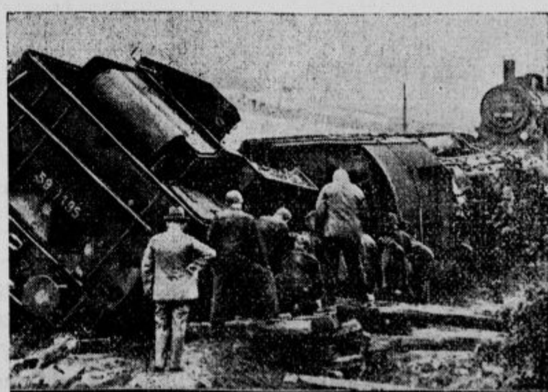
Povodenj je spodjedla dvotirni železniški nasip v bližini vasi Hermsdorf. Ko je vozil tovorni vlak čez nasip, se je ta sesedel, vlak pa je iztiril in se prevrnil. Takoj po povodnji so bile možne le avtobusne zveze, ker je bila vsa pokrajina poplavljen. Po kalni vodi je plavalo mnogo utopljene živine.
