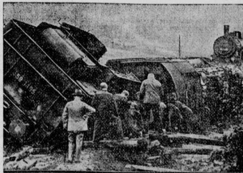
Povodenj je spodjedla dvotirni železniški nasip v bližini vasi Hermsdorf. Ko je vozil tovorni vlak čez nasip, se je ta sesedel, vlak pa je iztiril in se prevrnil. Takoj po povodnji so bile močne le avtobusne zveze, ker je bila vsa pokrajina poplavljen. Po kalni vodi je plavalo mnogo utopljenih živali.
