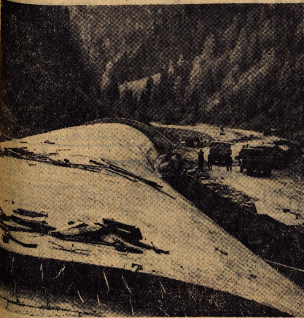
Begunjski plaz letos ne bo več zgrmel na cesto — predor pod njim (»snegobrane«) je skoraj že dograjen
