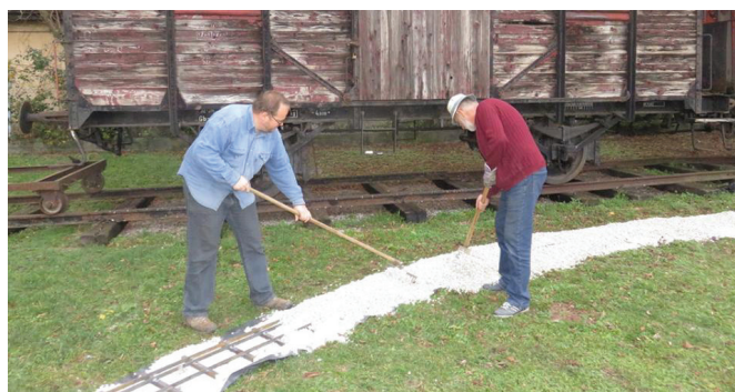
Plast planuma proge je treba razporediti z grabljami, da nanos kamnitega drobirja sega do zgornjega roba pragov, tako da ti ostanejo vidni.
