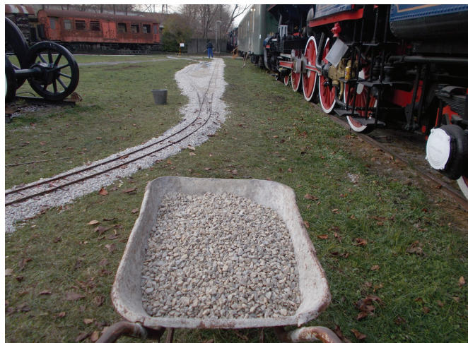
Na tamponsko plast pride plast planuma proge (kamniti agregat z velikostjo zrna od 8 do 18 mm)
