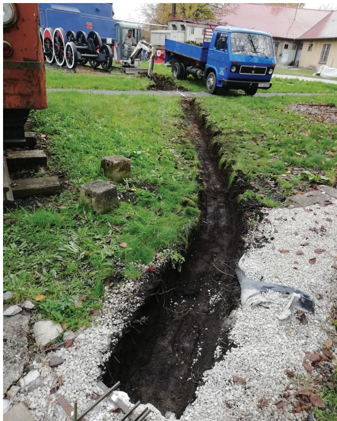
Strojni izkop trase širine 40 cm
