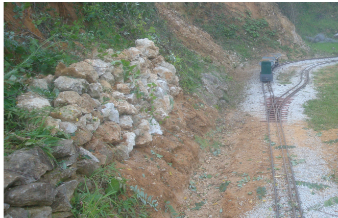
Brežine usekov morajo biti oblikovane tako, da je zagotovljena njihova stabilnost v vseh vremenskih razmerah.
