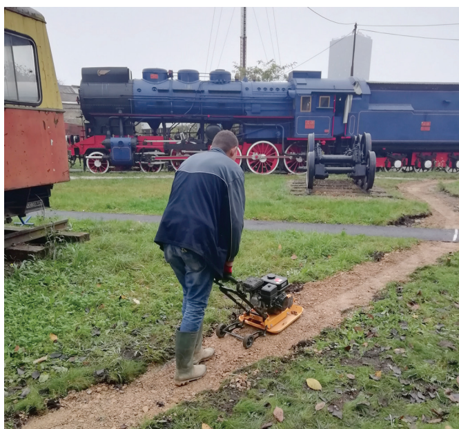
Po izkopu sledi nasipanje tamponske plasti in nabijanje z »žabico«.
