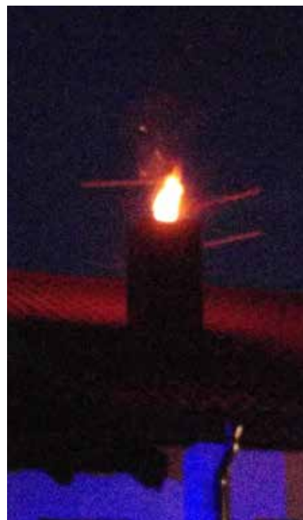
Prikazuje tretjo fazo (plameni segajo skozi kapo dimnika)
