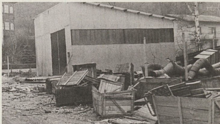
Lopo za maziva smo predstavili z zahodnega dela tovarne (ob bajerju) na prostor za menzo. Ob bajerju je potreben prostor za novo skladišče.
