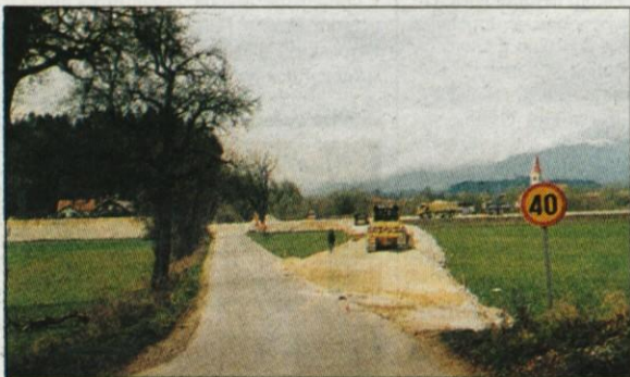
Na cesti Dob-Gorjuša je že vse pripravljeno na gradnjo bodoče ceste, ki bo potekala nad avtocesto. Trasa avtoceste je tudi že speljana in je v teh dneh poln po motoriste, sprehajalca, za marsikoga pa tudi bližnjica do Domžal.
