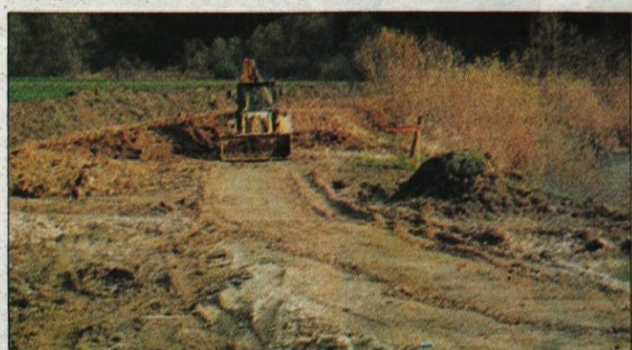
Za povečanje poplavisne varnosti naselja že poteka gradnja protipoplavnega nasipa ob Rači ob Bistrici do mostu na Podrečju.
