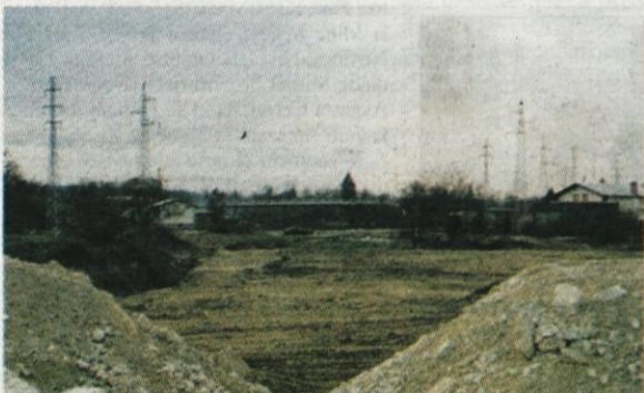
Ob cesti Domžale-Ihan že lahko občudujemo bodoči viadukt, po katerem se bomo po dokončanju avtoceste vozili v ta del naše občine.
