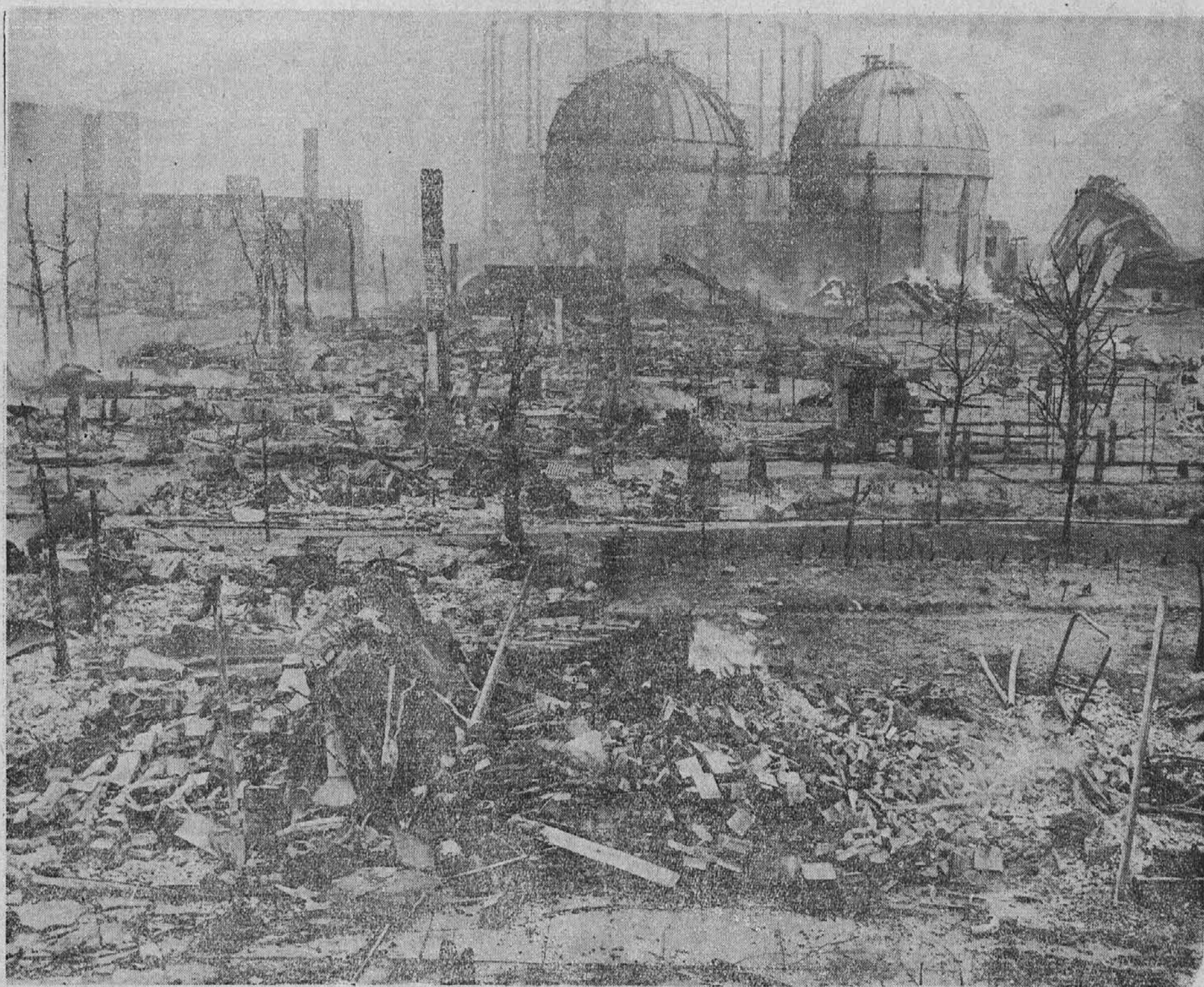
Tukaj imajo čitatelji, ki niso videli strašne katastrofe v slovenski naselbini v Clevelandu, vsaj nekaj pojma, kako izgleda zdaj. To je samo del 61. ceste, zdej vidite stati še dva tanka od East Ohio Gas Co., na desni pa vidite enega izmed razbitih tankov. Zadej za tovarno, ki jo vidite v gornjem levem kotu, je Lake Court, kjer je pogorelo 24 izmed 27 hiš.
