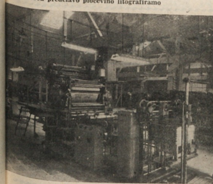
Pred predelavo pločevino litografiramo
