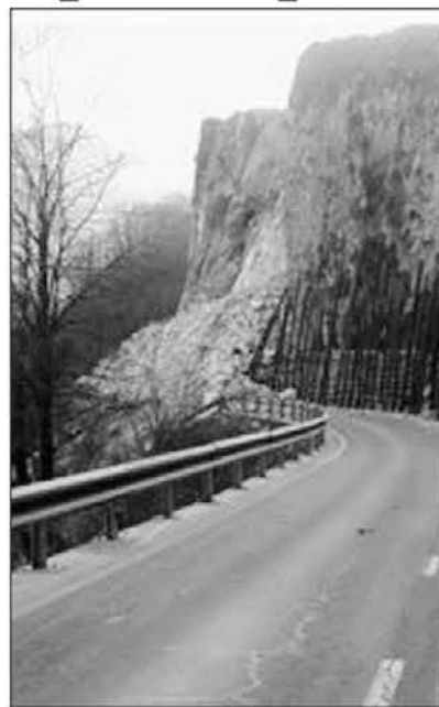
Odsek ceste med Kobaridom in Bovcem
