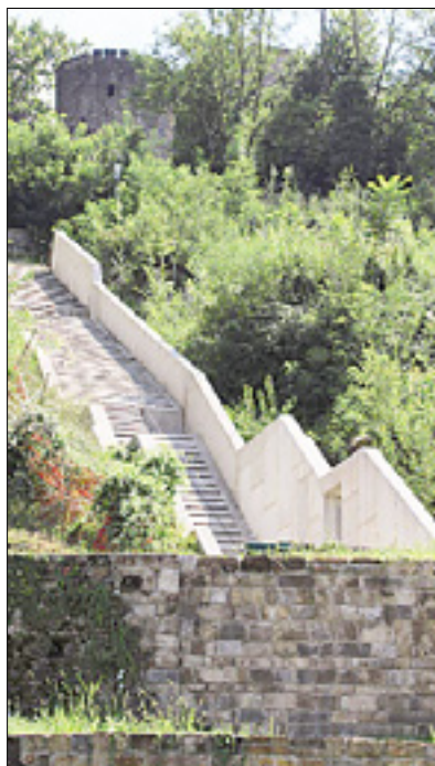
Gradbišče grajske vzpenjače
