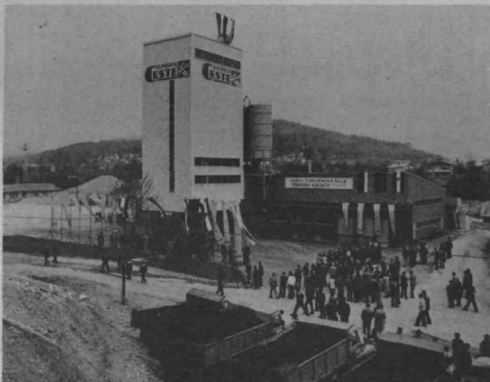
Za komandnim pulmom tovarne asfalta SGP Slovenija ceste na Črnučah bosta le dva delavca. S pritiski na gumbe bosta obvladala proizvodnjo 300 ton asfaltne mešanice na uro.
