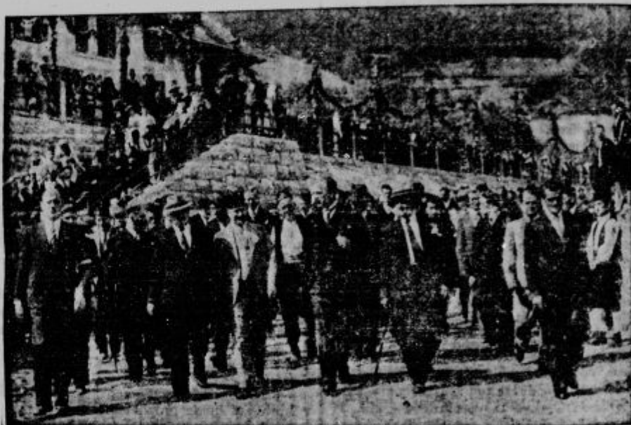
Slovesna otvoritev železniške proge Ustiprača—Poča. Prometni minister inž. Bešlič med odlič- niki pred postajo Ustiprača. Nova proga je ena najlepših, kar se jih je gradilo na ozemlju naše države. Dolga je 42 km in se jo gradili štiri leta.
