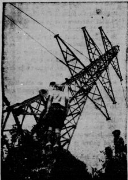
Bano vinske elektrarne gradijo pri Trbovljah mo- gočen daljnovod. Slika nam prikazuje, kako de- lavci na strmem grebenu postavljajo velik železen jambor na progi Trbovlje—Podleg.
