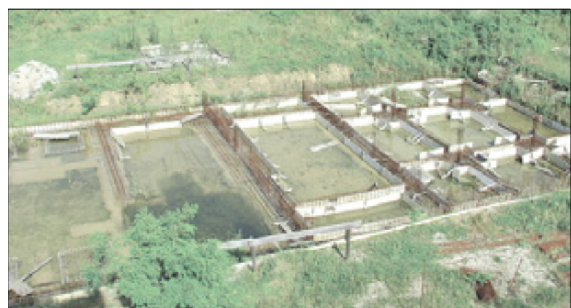
Na opuščnem gradbišču bodo že v ponedeljek začeli z gradnjo
