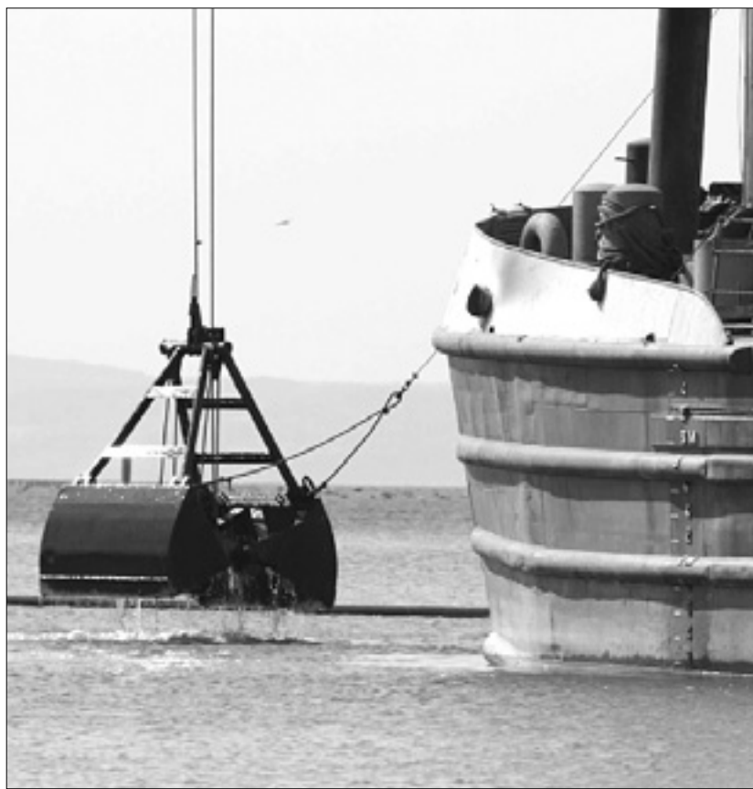
Začetek poglobljanja kanala Est-Ovest
