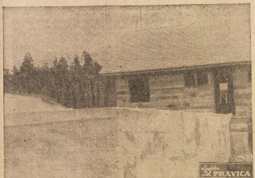
Hišica stanovanjske kolonije za Jožefovim hribom, spredaj betonski temelji, ki je bil zaman postavljen.
