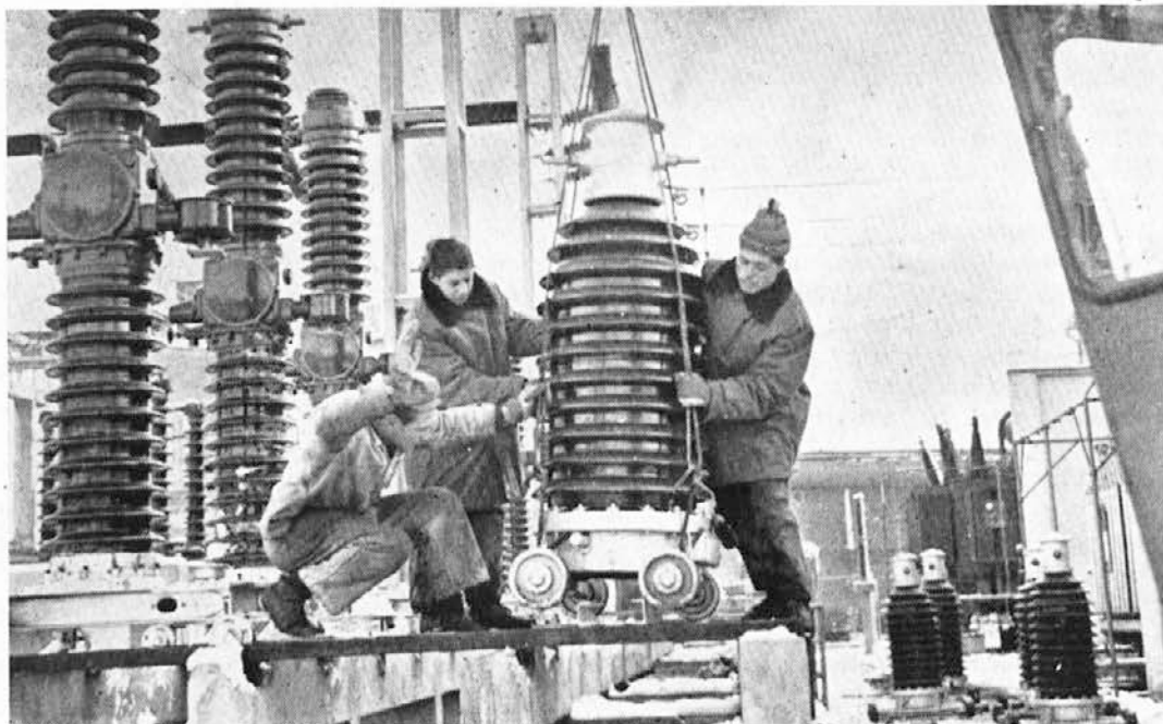
Montaža visokonapetostnega izolatorja
