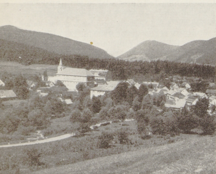
Znano zdravilišče Dolenjske Toplice so letos nadzidali za dve nadstropji in pridobili 86 novih ležišč. V gradili so tudi dvigalo
