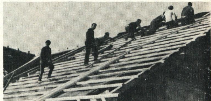
Posnetek z ene od delovnih akcij gradnje športnega doma v Kresnicah
