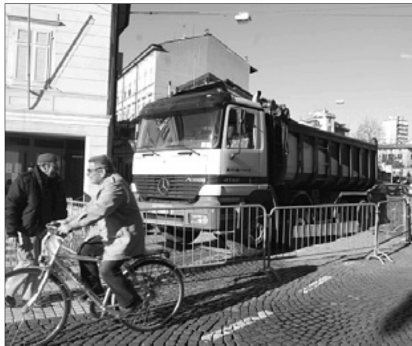
Gradbišče pred županstvom
