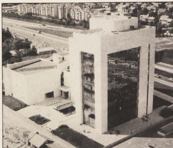
Predstavništvo Koroške hranilnice in Girozentrale je v Smeltovi stavbi v Ljubljani.
