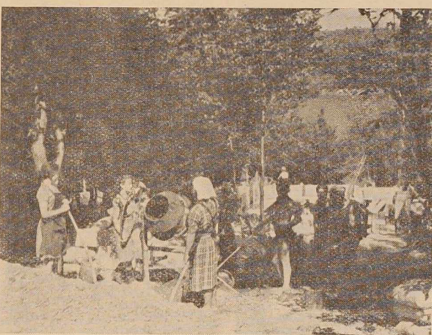
Ob Bukovniškem jezeru so v avgustu začeli graditi lovski dom
