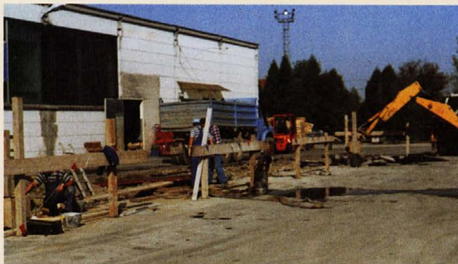
Temelji dozidave in pričetek gradnje
