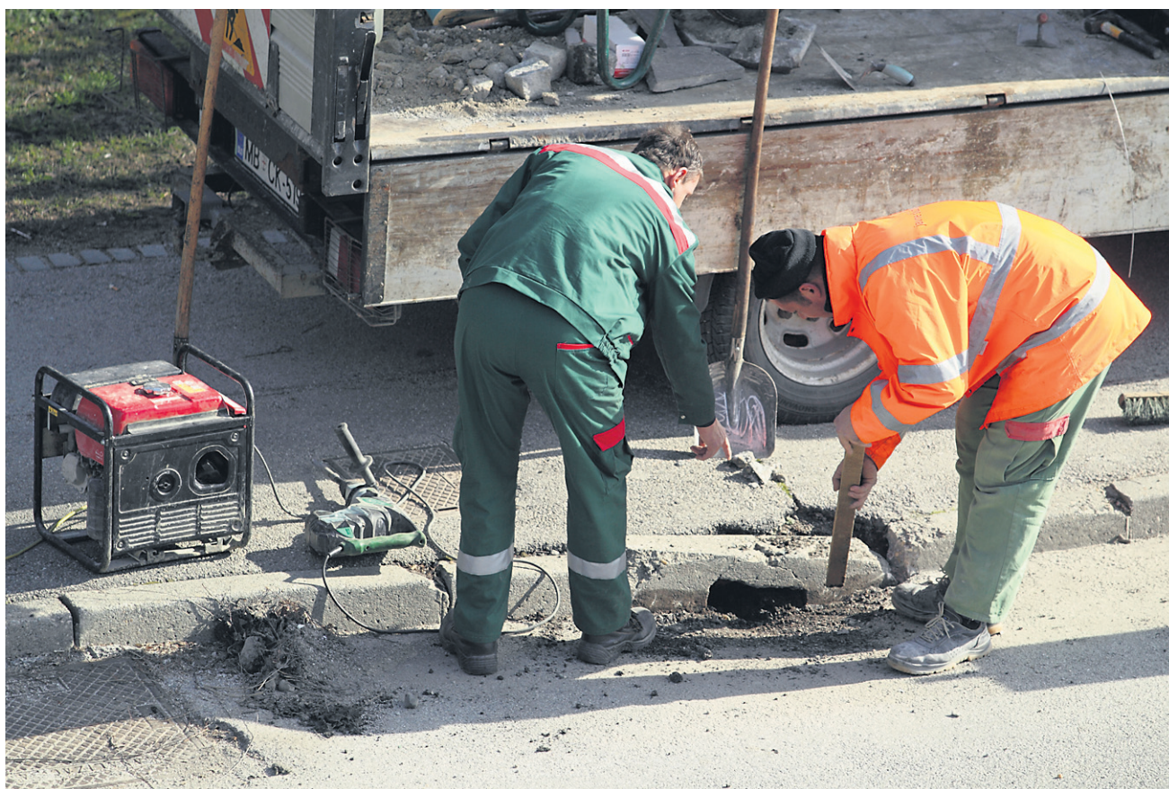
Več kot 70 odstotkov državnih cest je v mejnem, slabem in zelo slabem stanju. Brez ustreznega vzdrževanja jih bo v dveh letih kar 90 odstotkov v slabem in zelo slabem stanju. Ker je proračunskih sredstev za vzdrževanje cest vse manj, bi bilo treba zagotoviti stalen vir financiranja.
