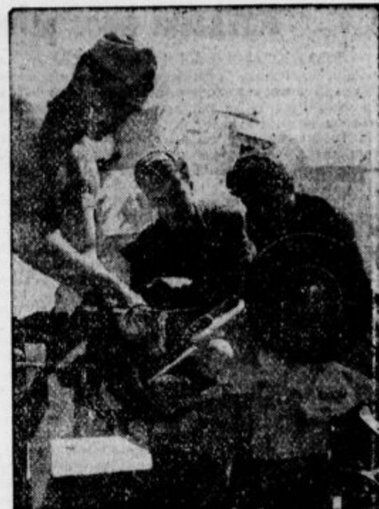
Prevozna delavnica, v kateri hitro popravljajo poškodbe na raznih motornih vozilih, na egiptovski fronti.
