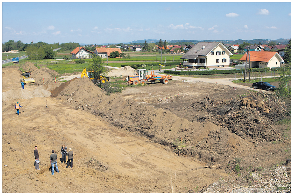
Gradbišče avtocestnega odseka Slivnica–Draženci
