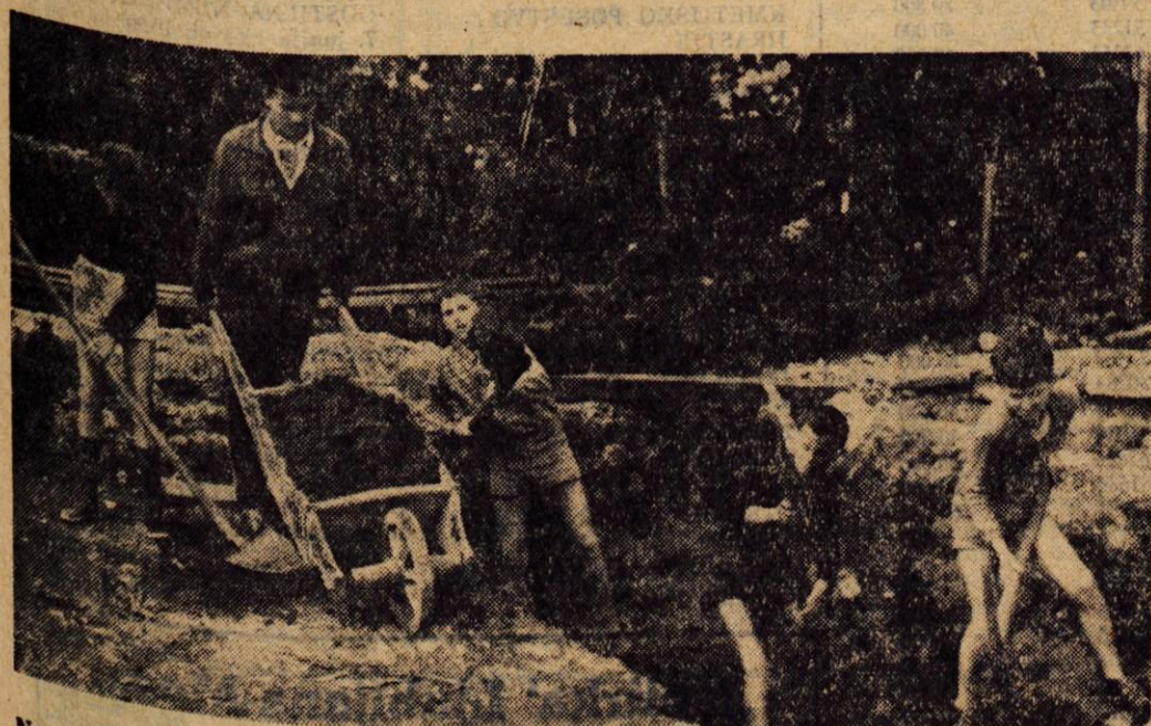
Naposed se je tabornikom odreda Svobodni Kamnitnik iz Škofje Loke le uresničila želja, da bodo prišli do svojih lastnih prostorov. Postavili si bodo montažno hišico v neposredni bližini gasivskega doma ob Sorl. Zemljska in ostala gradbena dela bodo opravili taborniki s prostovoljnim delom
