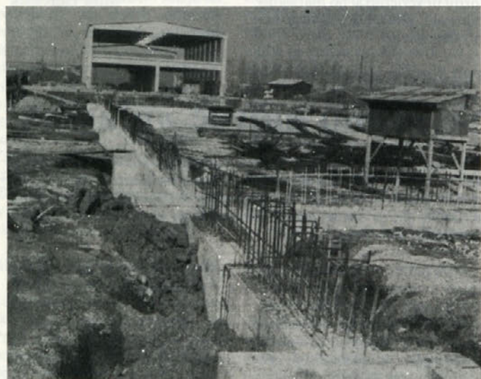
Temelji hale vzdrževalnih delavnic in ogrodje hale za proizvodnjo agresivnih medijev.
