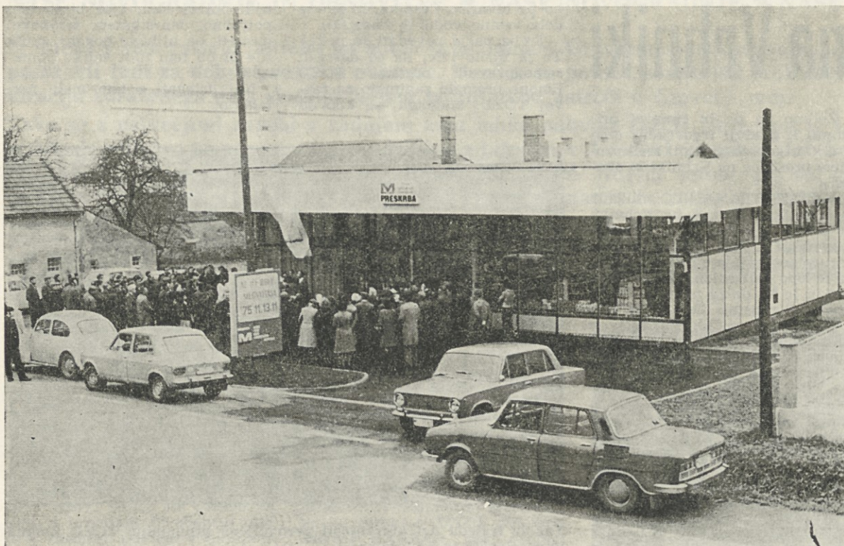
Objekt je montažnega tipa in so ga postavili v nekaj mesecih.
