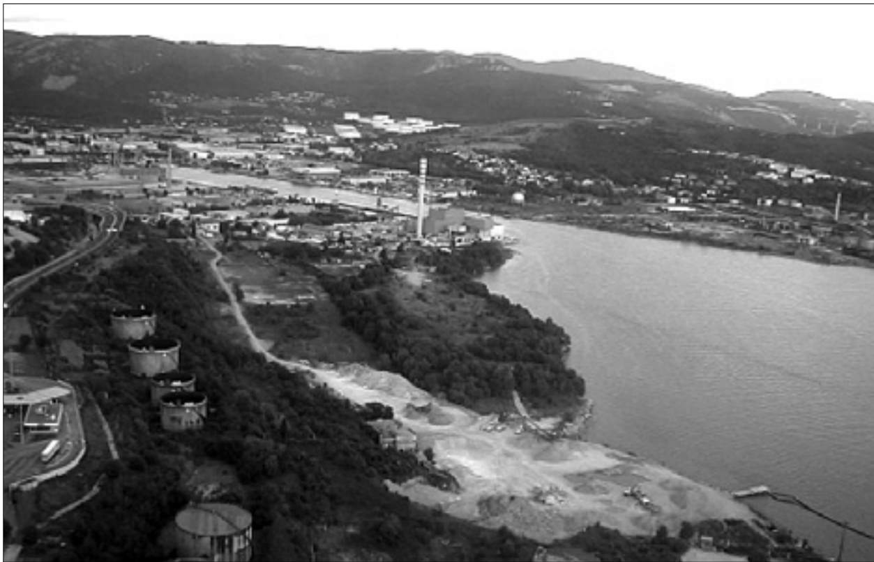
Območje pri Žavljah, na katerem namerava družba Gas Natural zgraditi plinski terminal
