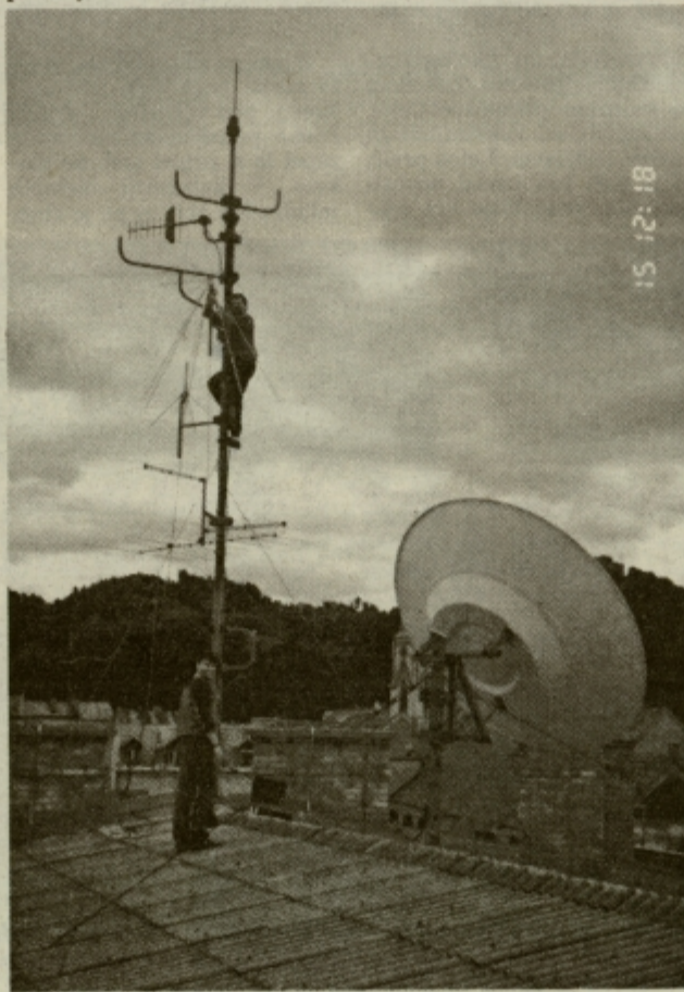
Tehnika naše radijske postaje Sašo Matelič in Mitja Tatarevič med montažo antene za pogovorne zveze.
