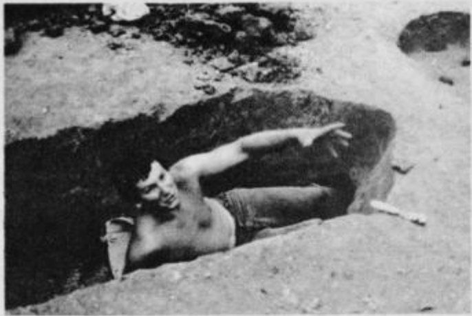
Na terenu opravlja Stanko Gojkovič tudi takšna, skorajda rudarska dela. (Foto OM)
