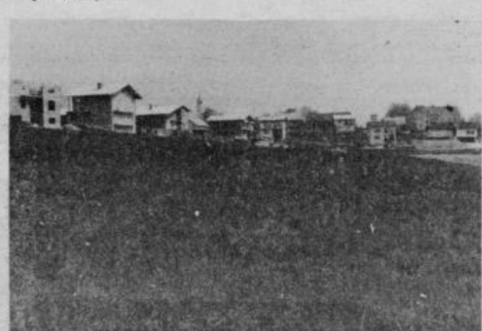
Okolje naselja Črešnjevec postaja z vsakim letom večje gradbišče zasebnih stanovanjskih hiš.
