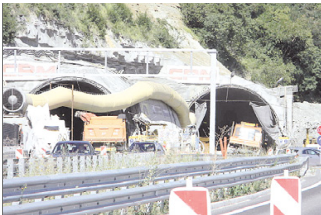
Na arhivskem posnetku gradbišče predora Markovec, ki buri duhove v Istri
