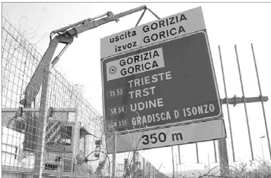
Nameščanje nove dvojezične table na avtocestnem odseku A34
