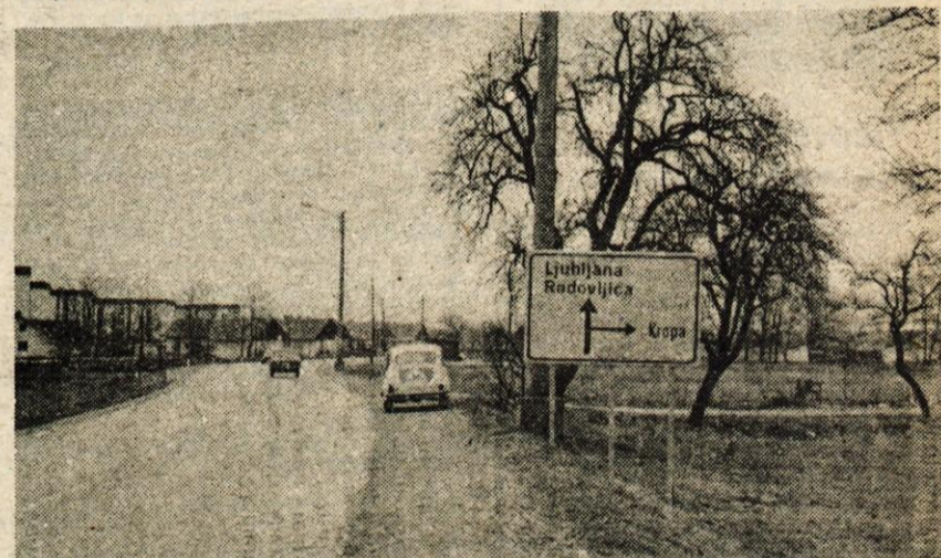
Ureditev križišča obvoznice — V radovljiški občini je bila ena pomembnih naložb v minulem letu obvoznica za lipniško dolino, ki naj bi razbremenila promet skozi Radovljico, predesem skozi Linhartov trg. Obvoznico in železniški nadvoz so zgradili, zdaj pa nameravajo vzporedno z izgradnjo kanalizacije Radovljica—Lesce urediti še križišče v Radovljici. — Foto: D. Kuralt
