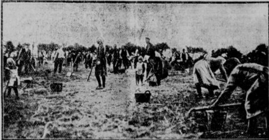
Zetev brezposelnih. Bedo brezposelnega delavstva in njihovih družin predločuje slika: ko so kmetovalci že pobrali krompir in druge pridelke, so se cele trume brezposelnih delavcev s svojimi ženami in otroci razkropile po poljih v bližini mest. Pobi rajo, kar je ostalo, da se s temi ostanki vsaj parkrat nasitijo.
