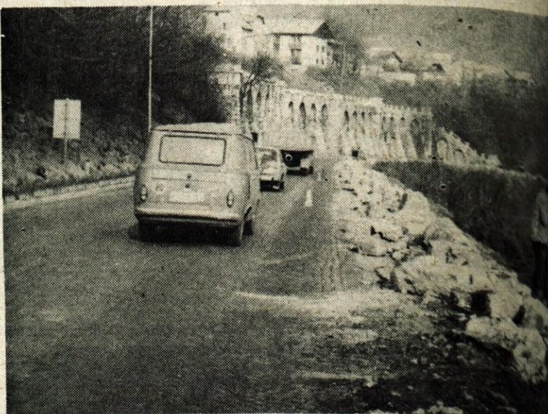
Kranj — Staro kamnito ograjo, ki je bila postavljena ob gradnji lanske ceste pred vojno in je varovala gaštevski klanec, so delavci cestnega podjetja iz Kranja te dni odstranili. Stara, dotrajana ograja in kamenje, ki se je ob raznih trkih krusilo, je ogrožala železniško progo spodaj. Kamenito bo te dni zamenjala kovinska odbojna ograja, ki bo dala pešcem dobrega pol metra več prostora. — Foto: D. Dolenc
