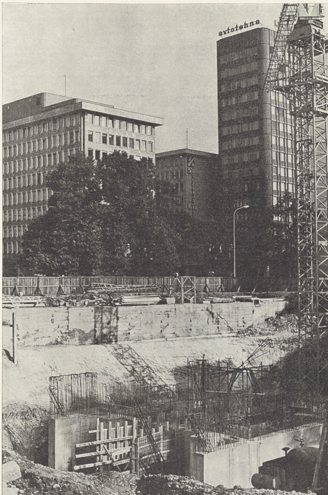
Ljubljana, 1974. O stari poslovni stavbi Mercatorja na bivši Tyrševi cesti ni več sledu. Že pred leti se je umaknila načrtom arhitektov, ki zdaj na tem mestu grade moderno stolpnico.
