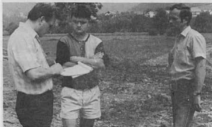
Na delovišču na Ledinici, kjer so delavci Vodnogospodarskega podjetja iz Kranja začeli z regulacijo
