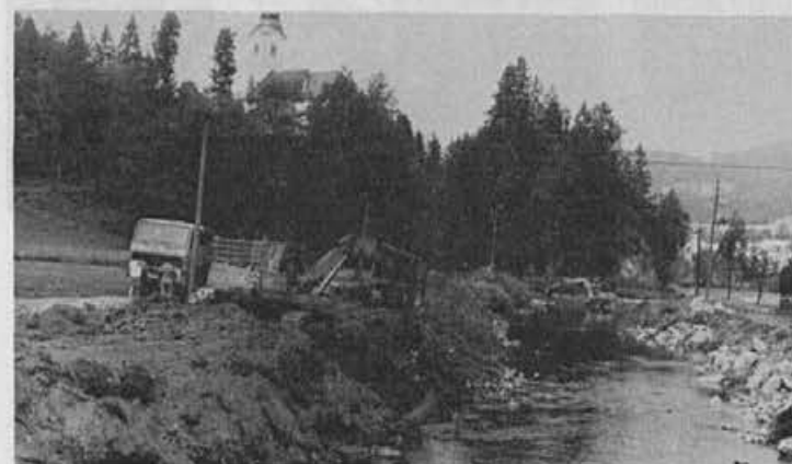
Najprej groba dela na bregovih in izkop struge, kasneje oblaganje in zaščita
