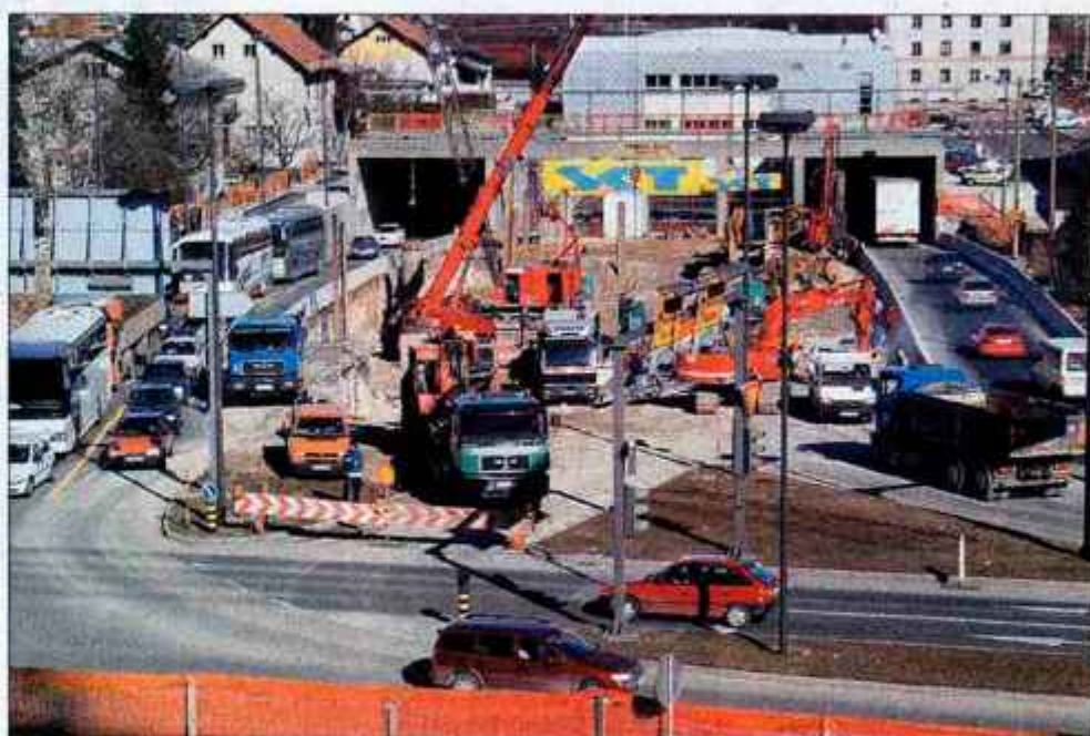
Na južnem koncu gorenjske avtoceste je veliko gradbišče; tam bodo podaljšali galerijo Šentvid.
