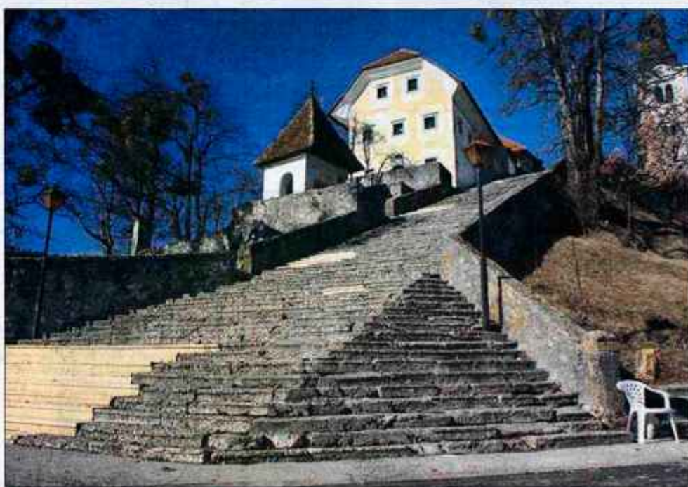
Kamnite stopnice so med obnovo nadomestili z lesenimi, tretjino stopnic pa bo treba zamenjati z novimi.
