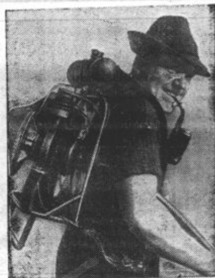
V Nemčiji so konstruirali majhen prenosljiv motor, uporaben predvsem v poljedelstvu. Motor je tako lahek, da se more nositi na hrbtu.
