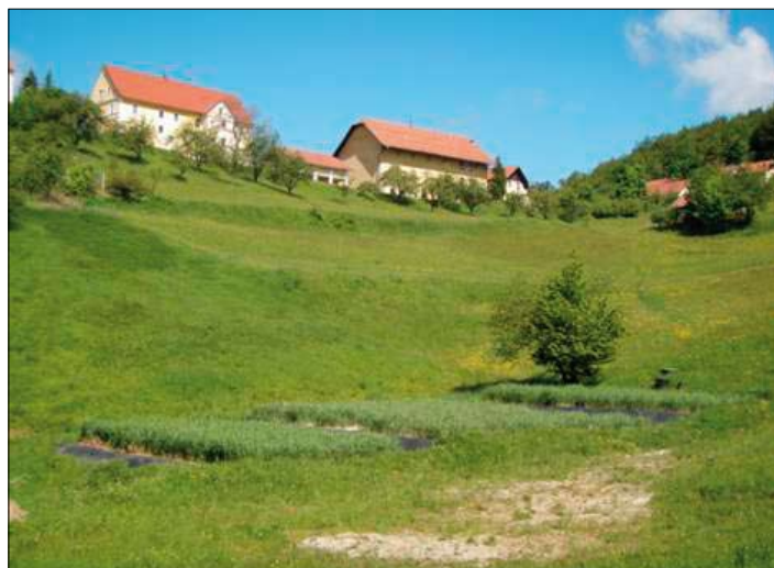
RČN za del naselja Dobje v občini Dobje s kapaciteto čiščenja 100 PE.
