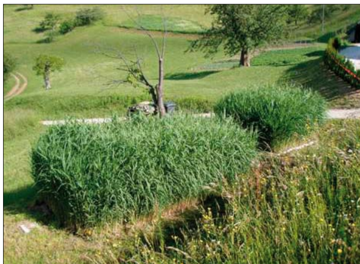
RČN za družinsko hišo v naselju Lindek s kapaciteto čiščenja 5 PE.
