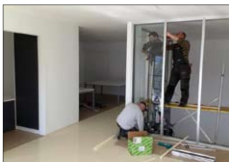
(december 2013) Prenova prostorov, foto: arhiv GROŠ
