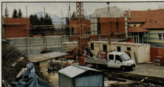
Gradnja nove telovadnice pri POŠ Trze
